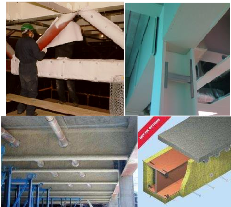
Figura 10. Aislamiento periférico de vigas y columnas
