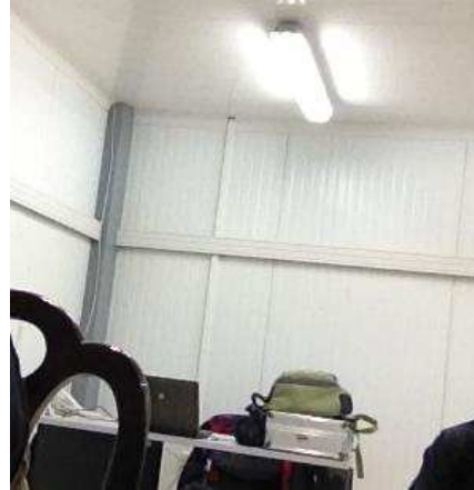
Figura 8. Columna sin aislante térmico en la estación PVM
