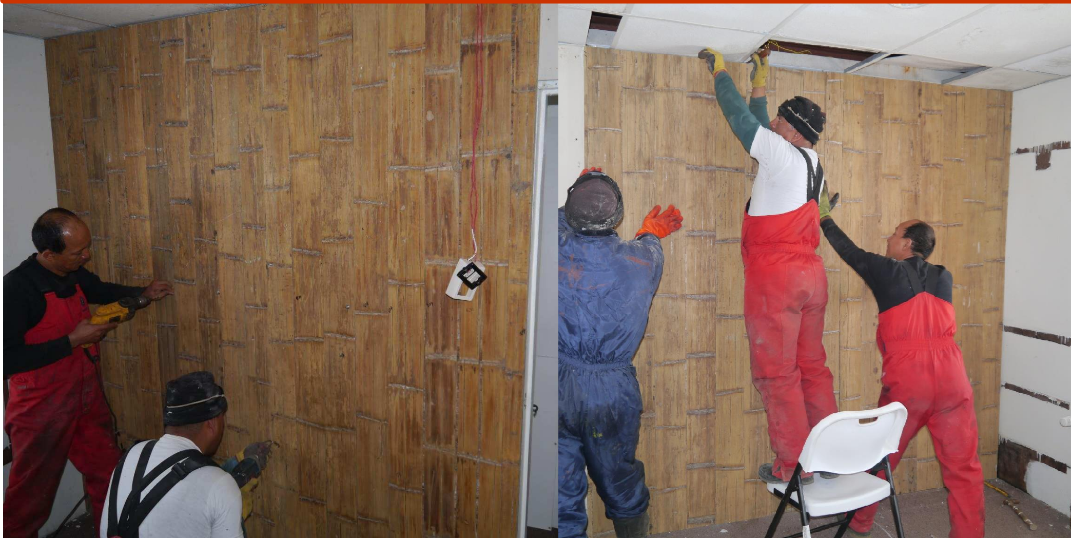
INSTALACIÓN DE PAREDES EN UN CAMAROTE
