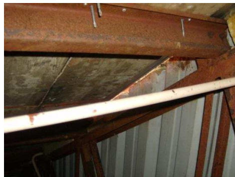
Figura 9. Infiltraciones en la cubierta en la estación PVM
