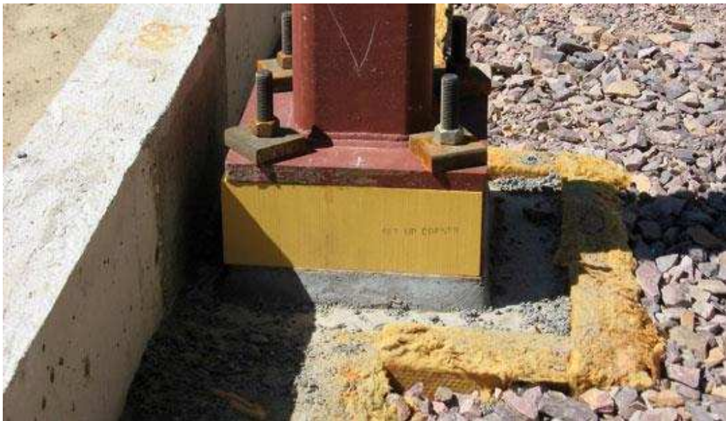
Figura 11. Aplicación de los bloques de soporte aislados
