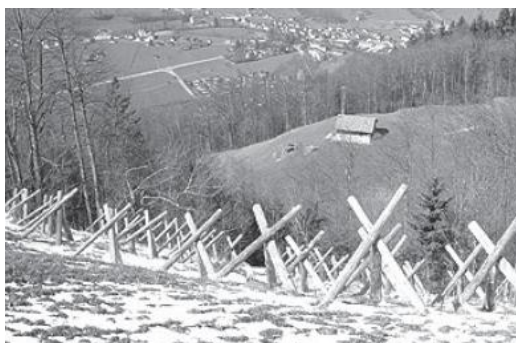
Figura 3. Trípodes de madera instalados en la ladera de una colina, para contrarrestar la acumulación de nieve.
