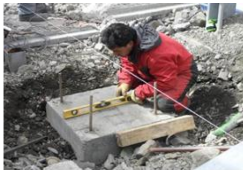
Figura 1. Fundaciones del nuevo emplazamiento de la base Escudero, levantado entre los módulos ya existentes.
