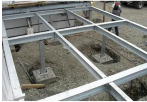
Figura 2. Vigas T o H montadas en las fundaciones establecidas.
