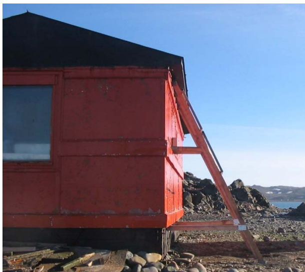
Estructura de soporte terminada.
