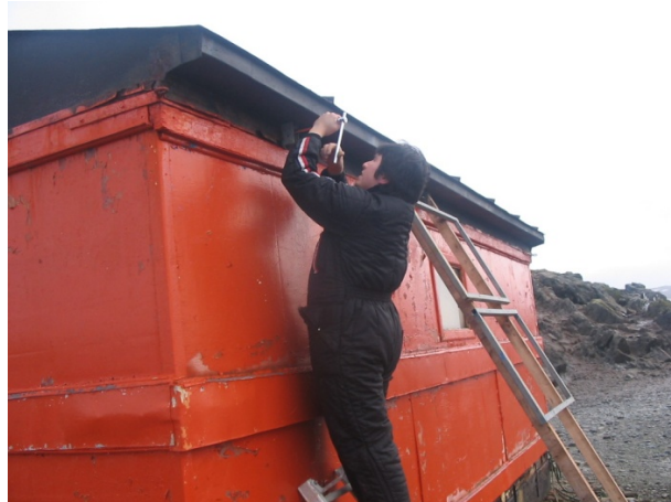
Anclaje de perfiles a muro para sujeción de maderos.
