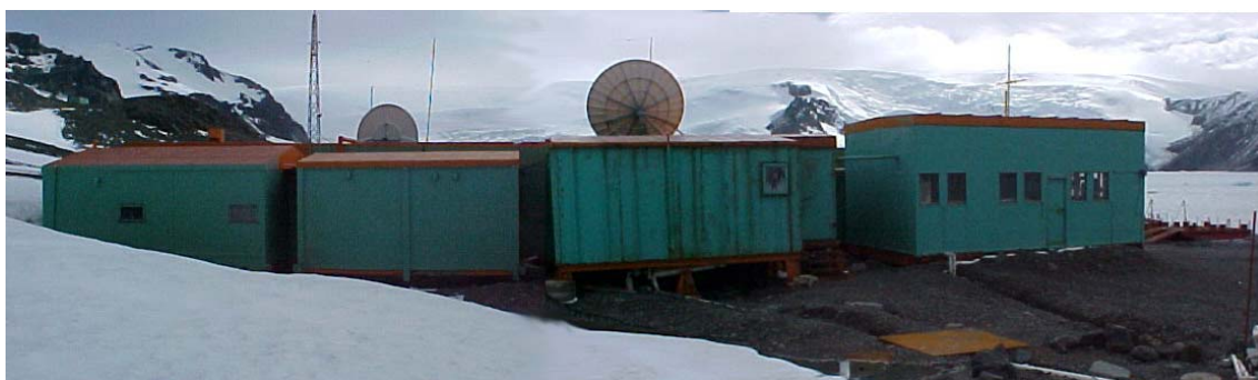
Figura 7 - Vista lateral da EACF onde são perceptíveis as reentrâncias e saliências oriundas do processo de crescimento por unidades compartmentadas (contêineres).
