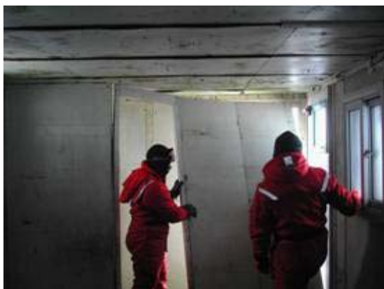
Figura 6 - Retirada das anteparas internas.
