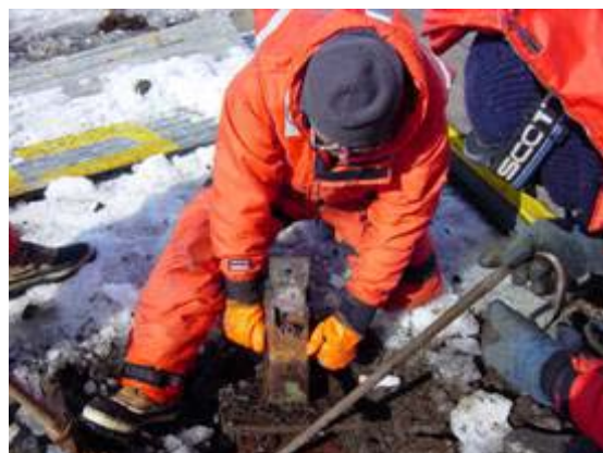
Figura 11 – Retirada das sapatas. Destaca-se que a não utilização de concreto facilitou a retirada dos elementos enterrados.
